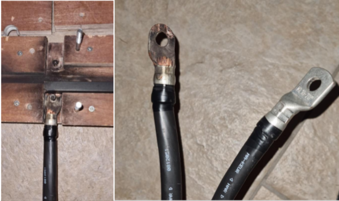
Afbeelding 20 en 21: Op de rechter afbeelding zijn de twee verschillende ogen van de accukabels zichtbaar en op de linker afbeelding is zichtbaar hoe deze ogen met de rails worden vastgezet.
